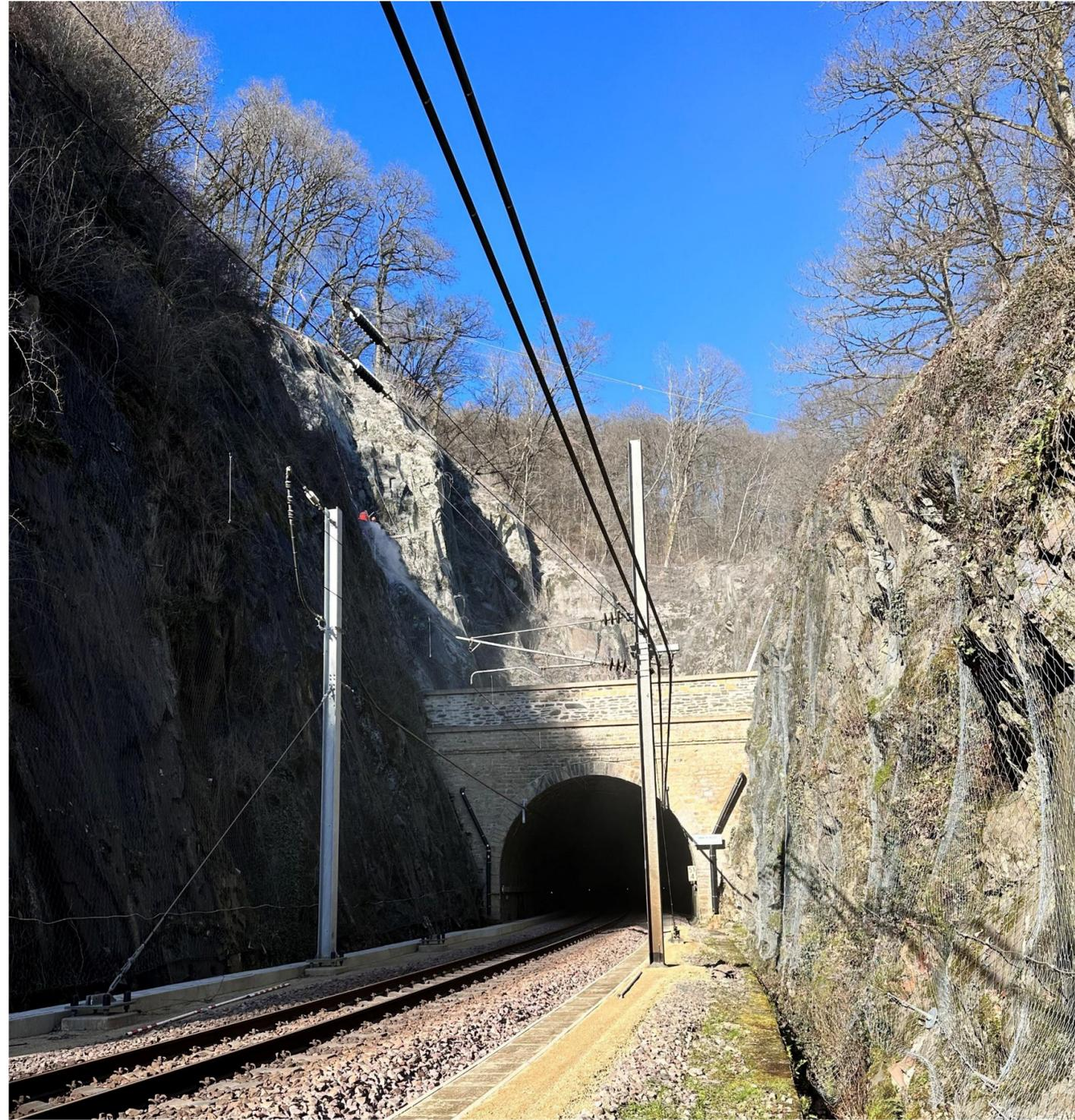
Une chambre d'éboulis est construite pour la protection du réseau ferré et du trafic ferroviaire.
